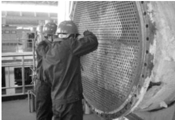
图 1 人工高压水枪清洗
