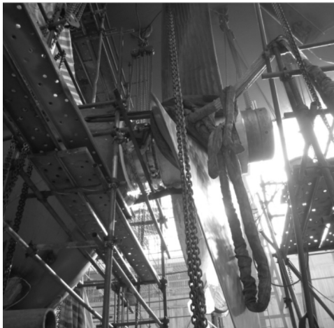
图2 螺旋桨安装完成
